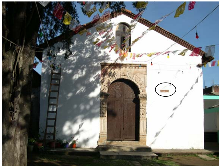
Fotografía 4: Capilla de barrio de San Pedro
