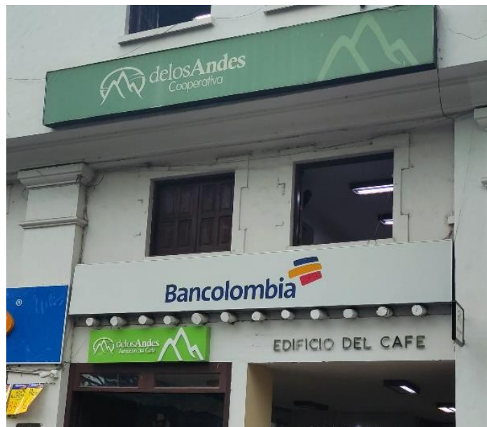
Ilustración 71 Fachada de edificio de Cooperativa de Los Andes, foto propia
