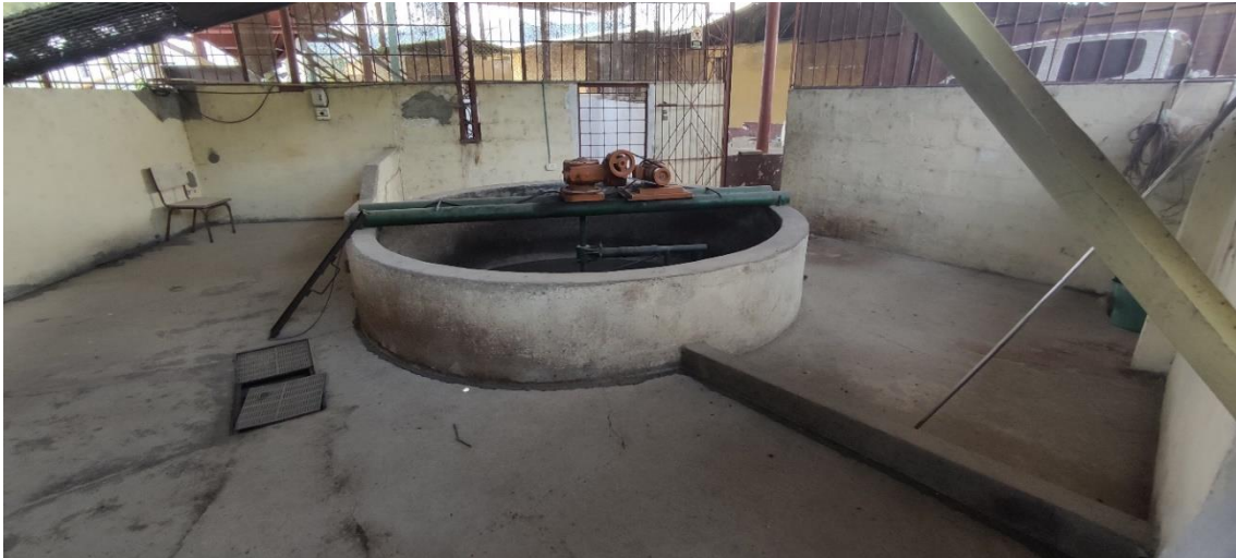
Ilustración 63 Silo de carbón en beneficio, foto propia
