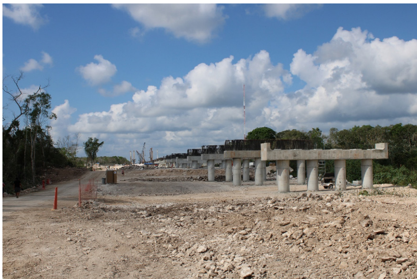
Figura 2. Viaducto elevado para la vía férrea, Playa del Carmen, Quintana Roo, 2024.
