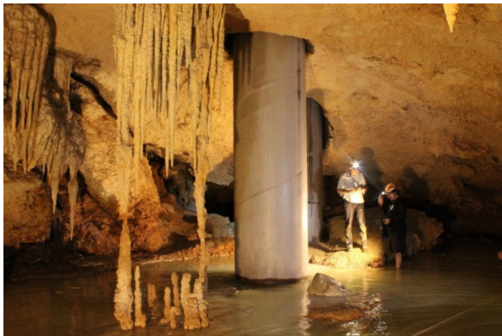
Figura 3. Cueva Oppenheimer perforada por el viaducto elevado, Playa del Carmen, Quintana Roo, 2024.
