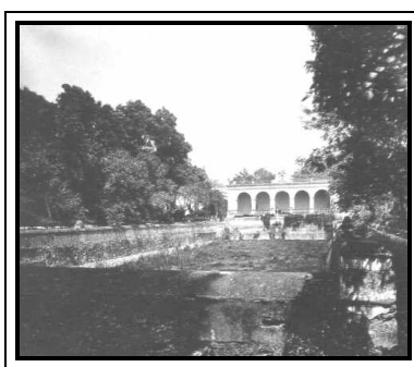
Imagen 103. Fotografía: Caja de Agua.
