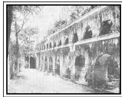
Imagen 105. Fotografía: “Ruinas del Acueducto del Carmen”.
