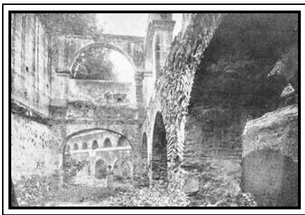
Imagen 104. Fotografía: “Ruinas del Acueducto del Carmen”.
