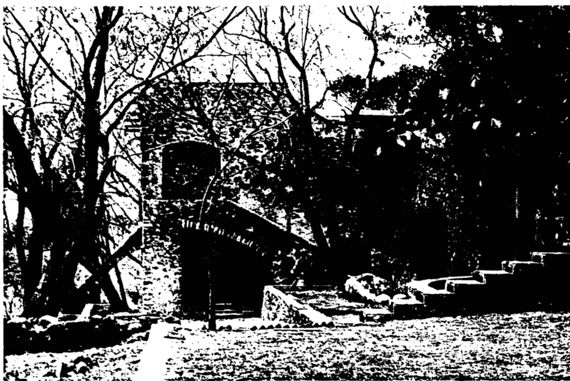
CASA DEL APARTADO Y FUNDICION
