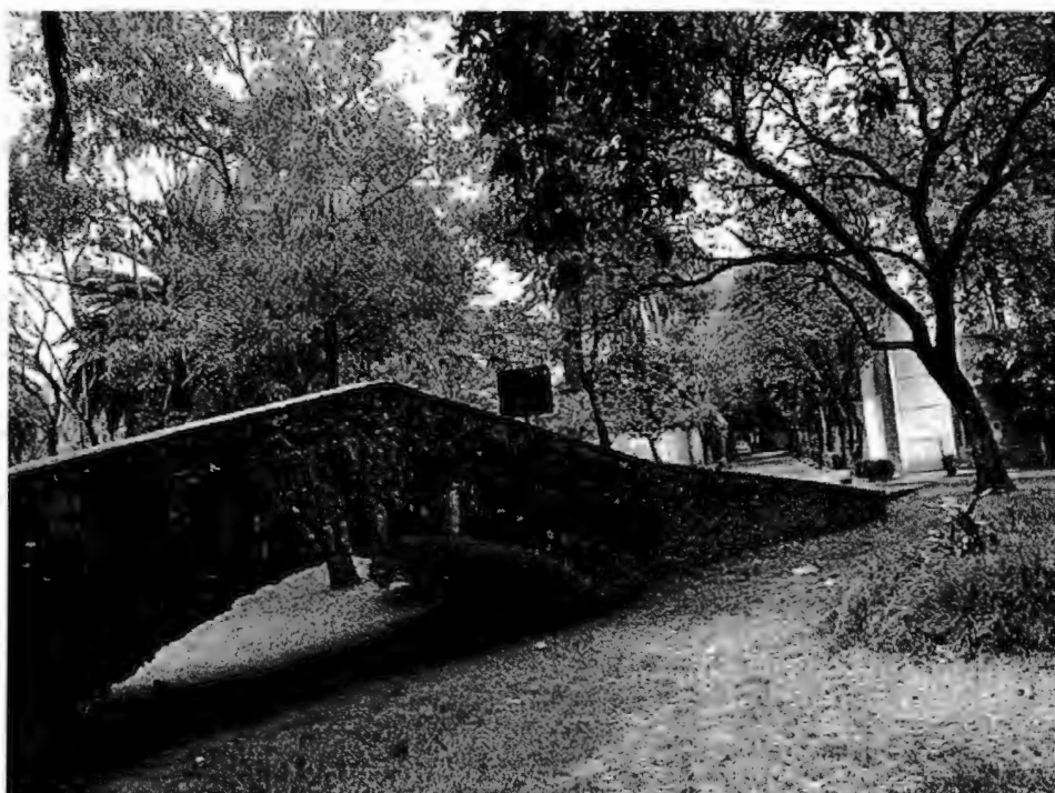
Puente de piedra en el camellón del Paseo del Río, Chimalistac, DF. Antonio Zirión. 20 de marzo de 2006.
