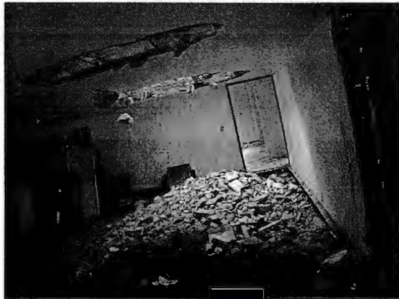
La casa de Checa #18 en proceso de demolición 1. Chimalistac, DF. Antonio Zirión. 11 de enero de 2006.
