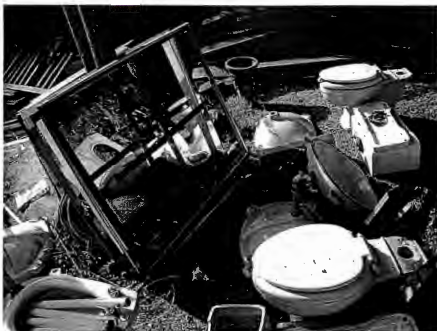
Muebles desmontados. Demolición de la casa de Checa #18, Chimalistac, DF. Antonio Zirión. 11 de enero de 2006.
