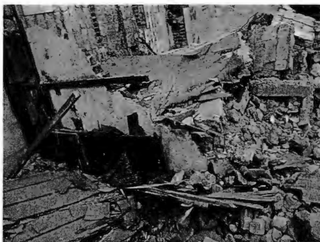
Escombros 2. Demolición de la casa de Checa #18, Chimalistac, DF. Antonio Zirión. 13 de febrero de 2006.
