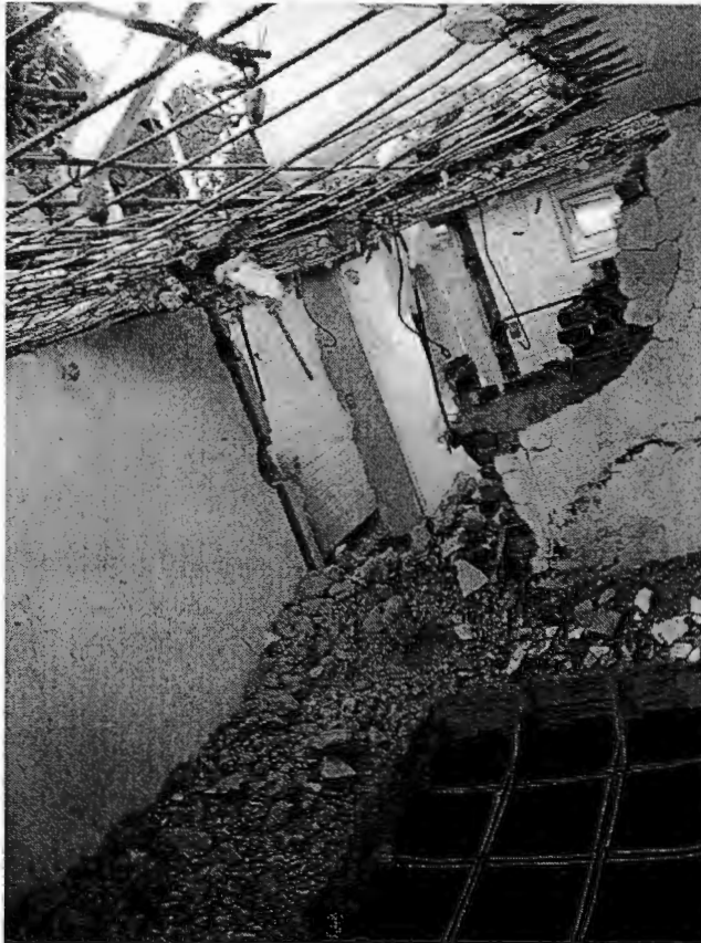
La casa de Checa #18 en proceso de demolición 4. Chimalistac, DF. Antonio Ziri3n. 16 de enero de 2006.
