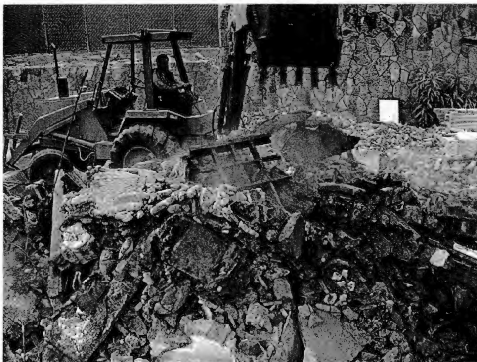
La máquina en acci6n. Demolici6n de la casa de Checa #18, Chimalistac, DF. Antonio Ziri6n. 31 de enero de 2006.
