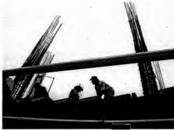
Castillos de varilla sobresalen de una construcción en la calle Dinamarca, Zona Rosa, DF. Antonio Zirión. 3 de julio de 2003.
