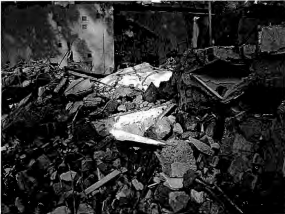
Escombros 5. Demolición de la casa de Checa #18, Chimalistac, DF. Antonio Zirión. 31 de enero de 2006.
