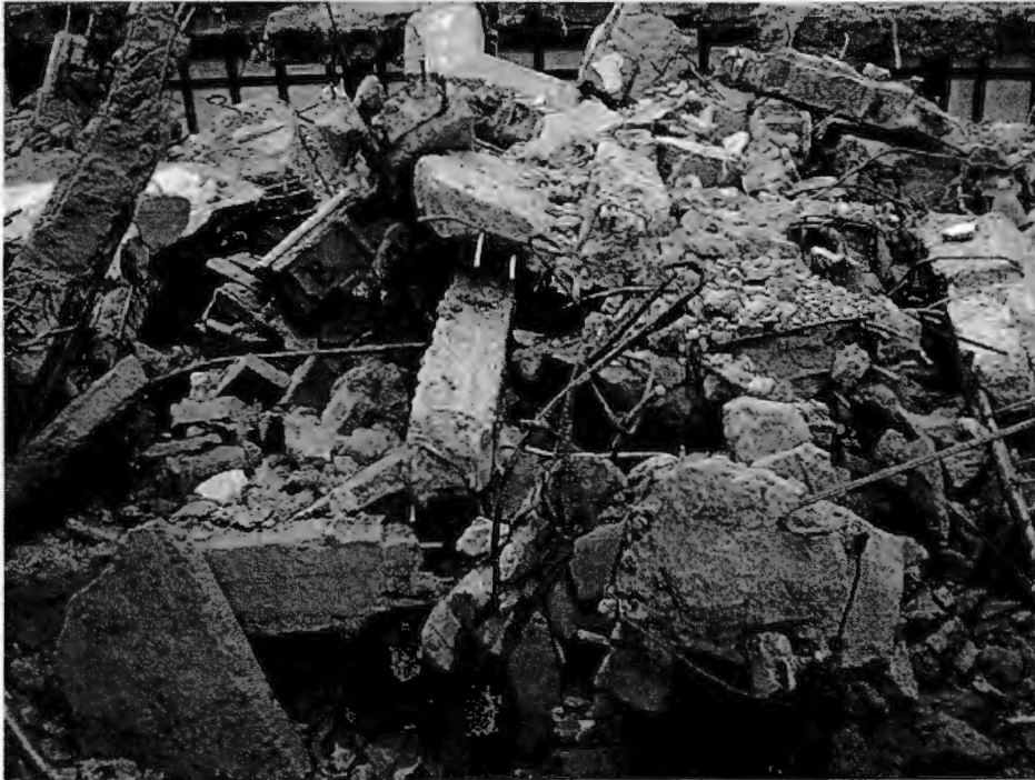
Escombros 4. Demolición de la casa de Checa #18, Chimalistac, DF. Antonio Zirión. 23 de enero de 2006.
