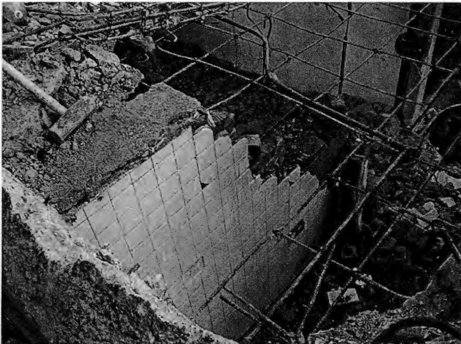
La casa de Checa #18 en proceso de demolición 5. Chimalistac, DF. Antonio Ziri3n. 16 de enero de 2006.
