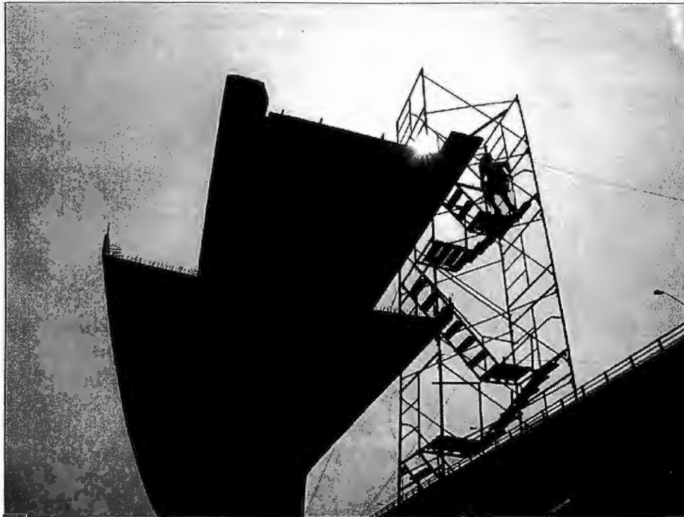
Andamio en la obra del Segundo Piso de Periférico. San Ángel, DF. Antonio Zirión. 31 de enero de 2006.
