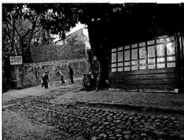
Trabajo en equipo en la demolición de Checa #18, Chimalistac, DF. Antonio Zirión. 31 de enero de 2006.
