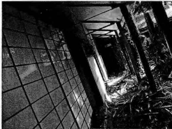
La casa de Checa #18 en proceso de demolición 2. Chimalistac, DF. Antonio Zirión. 16 de enero de 2006.
