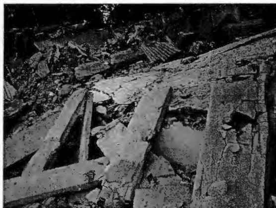
Escombros 3. Demolición de la casa de Checa #18, Chimalistac, DF. Antonio Zirión. 23 de enero de 2006.
