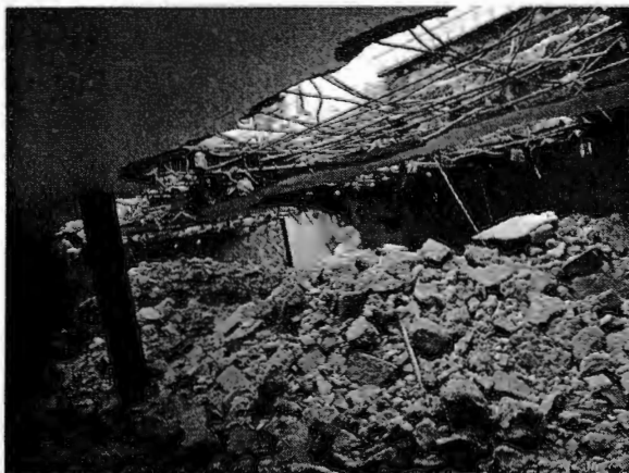
La casa de Checa #18 en proceso de demolición 3. Chimalistac, DF. Antonio Zirión. 16 de enero de 2006.
