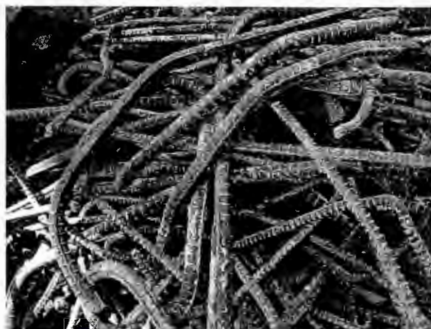
Varillas retorcidas. Demolición de la casa de Checa #18, Chimalistac, DF. Antonio Ziri6n. 7 de marzo de 2006.
