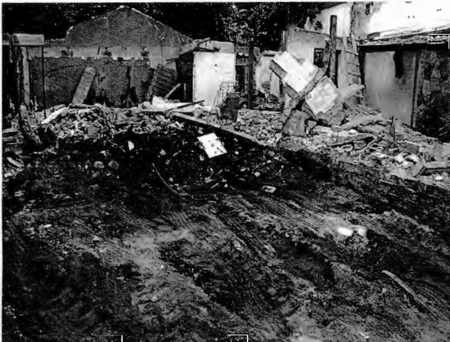
La casa de Checa #18 en proceso de demolición 13. Chimalistac, DF. Antonio Zirión. 9 de febrero de 2006.
