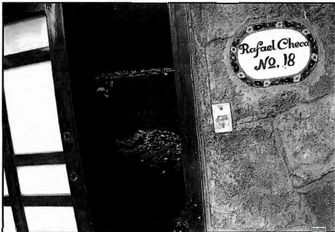
Puerta de entrada a la casa de Checa #18 en proceso de demolición. Chimalistac, DF. Antonio Ziri3n. 11 de enero de 2006.
