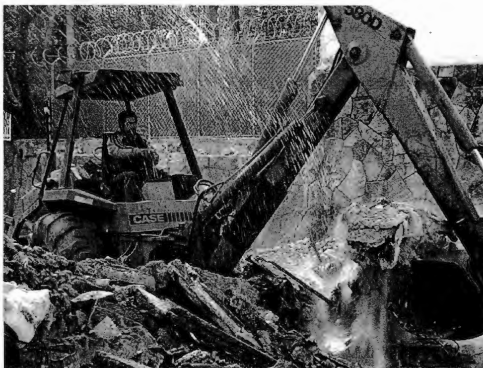
La máquina recogiendo escombros. Demolición de la casa de Checa #18, Chimalistac, DF. Antonio Ziri6n. 31 de enero de 2006.
