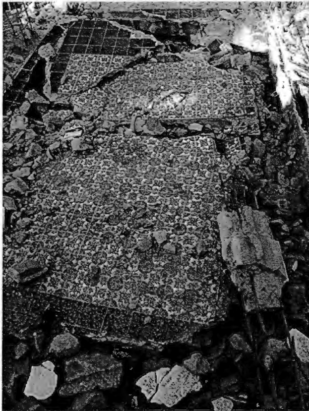
Pared de azulejos tumbada. Demolici6n de la casa de Checa #18, Chimalistac, DF. Antonio Ziri6n. 13 de febrero de 2006.
