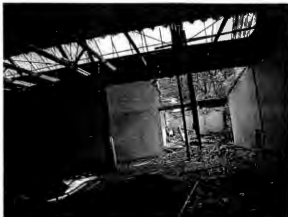
La casa de Checa #18 en proceso de demolición 6. Chimalistac, DF. Antonio Zirión. 19 de enero de 2006.
