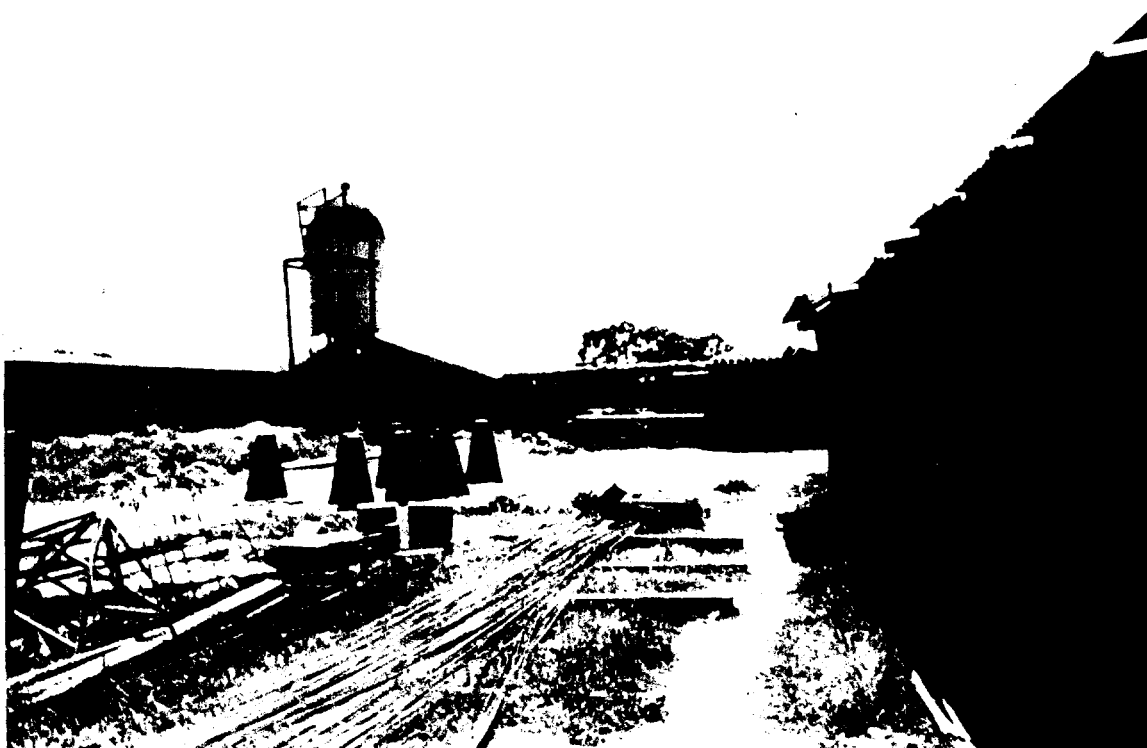
Exhacienda Mazaquíahuac; Viejo torreón de vigilancia en una esquina de la barda. Se observa material de construcción en su remodelación.
