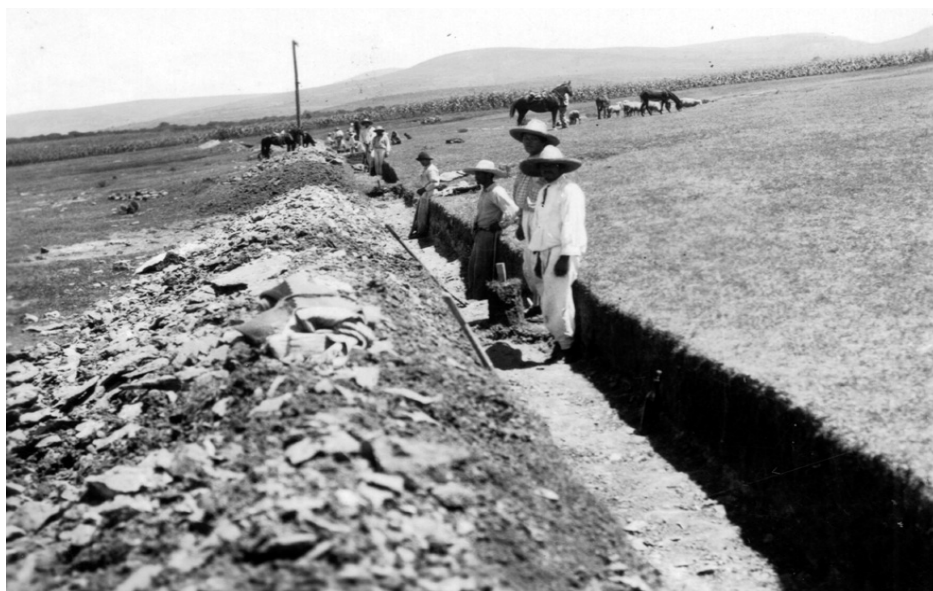
Foto 31. 1929 “Derivación río San Lorenzo, tramo canal nuevo”. AHA, Aprovechamientos Superficiales, caja 406, exp. 7716, foto 4. Foto 5. Inspección a las obras realizadas por convenio de la fábrica de Santiago para derivar y devolver las aguas del río San Lorenzo o Grande y de los manantiales los Cangrejos.
