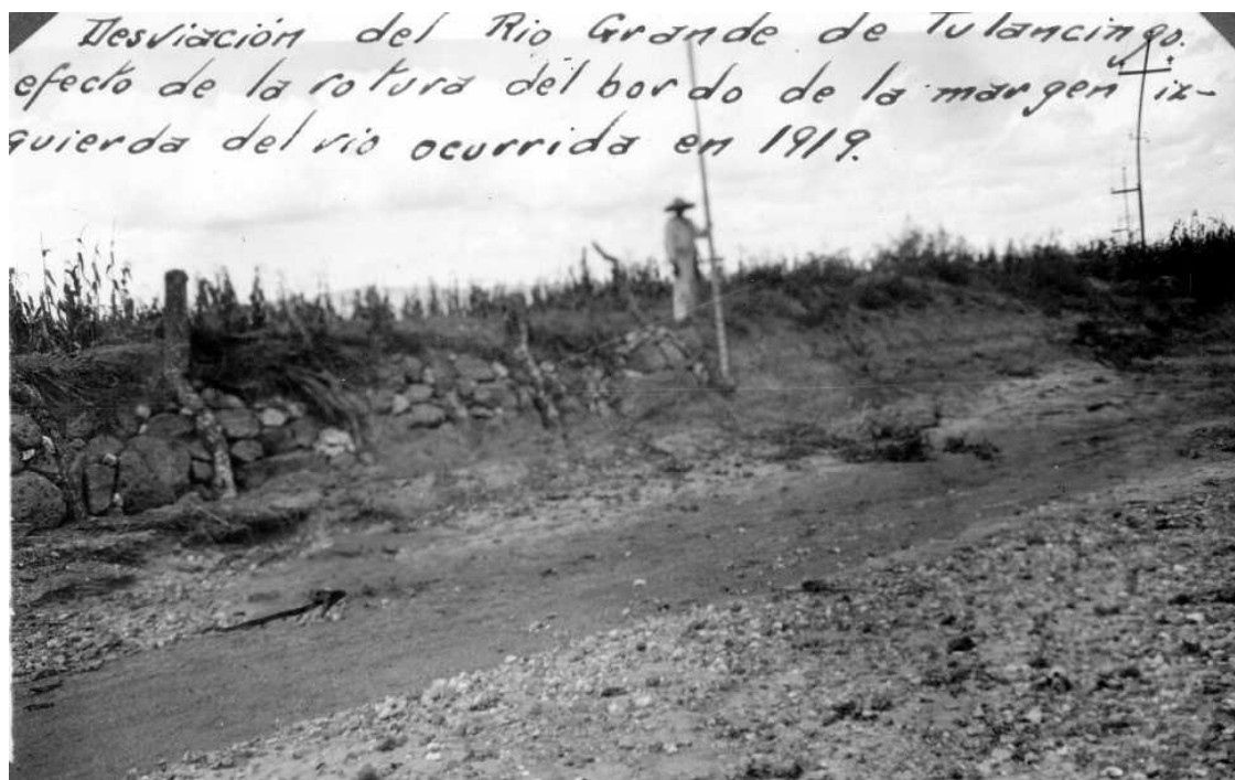
Foto 26. 1923 "Desviación del río Grande de Tulancingo. Efecto de la rotura del bordo de la margen izquierda del río ocurrida en 1919". AHA, Aprovechamientos Superficiales, caja 905, exp. 12890, foto 24.
