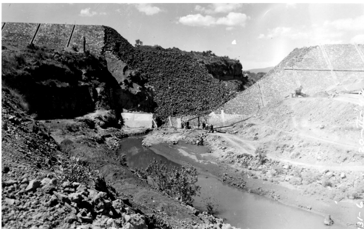
Foto 13. 21 de febrero de 1942. “Vista aguas abajo desde el camino que atraviesa el río aguas arriba de la presa”. Archivo Histórico del Agua, Consultivo Técnico, caja 305, exp. 2601, foto 63.
