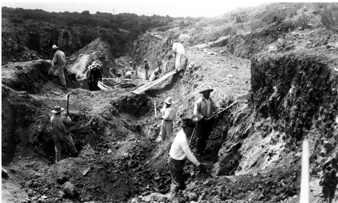
Foto 12. 25 de octubre de 1940. “Vista hacia aguas abajo a lo largo en el canal de descarga del vertedor de demasías, tomada desde un punto 25 metros aguas arriba del eje de la presa”. Archivo Histórico del Agua, Consultivo Técnico, caja 305, exp. 2601, foto 25.
