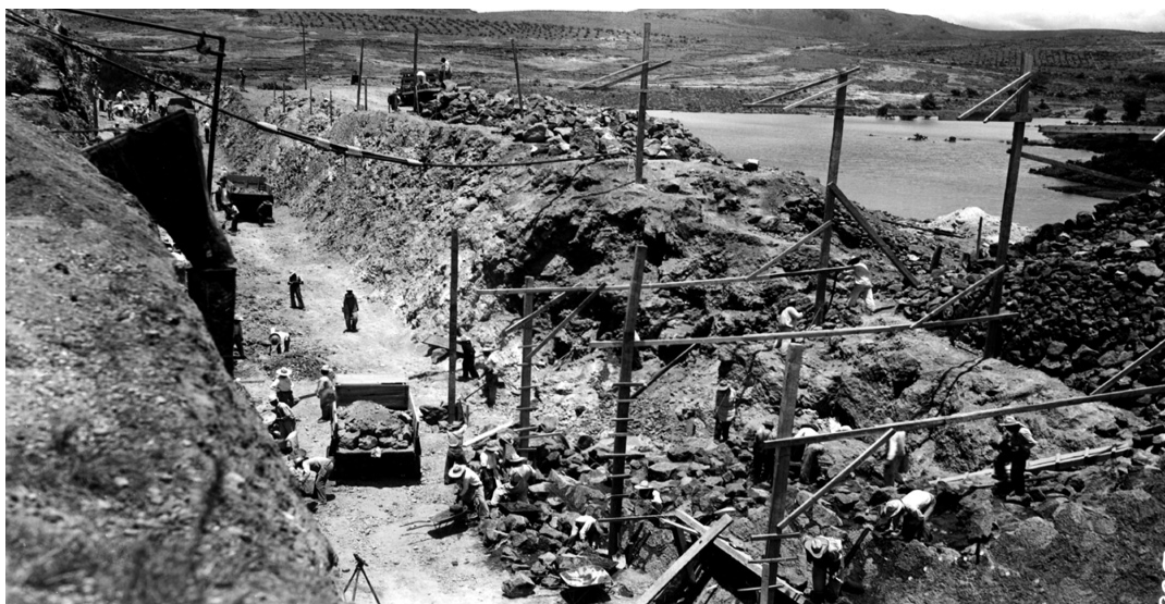
Foto 11. 21 de febrero de 1942. “Desde un punto unos treinta metros aguas abajo del eje de la presa”, “Vemos los materiales sueltos al lado izquierdo del canal receptor”. Archivo Histórico del Agua, Consultivo Técnico, caja 305, exp. 2601, foto 68.
